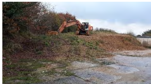
Vue sur les emprises techniques autour des bâtiments
